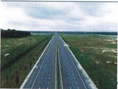
Tuyến đường chính KCN
